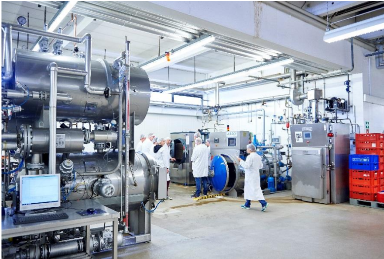
Bild 3: Im Technikum des KIN Lebensmittelinstituts steht den Lebensmitteltechnikern künftig auch eine Druckluftaufbereitungsanlage inklusive Messtechnik zur Verfügung. Bildquelle: KIN Lebensmittelinstitut e.V.
